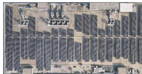
越南據點太陽能發電站建設
