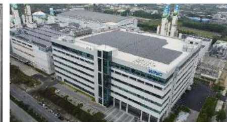
啓碁南科廠太陽能發電站
